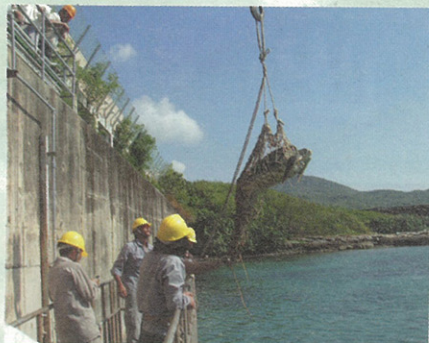
請來工地吊車協助將綠蠓龜吊至野放地點
