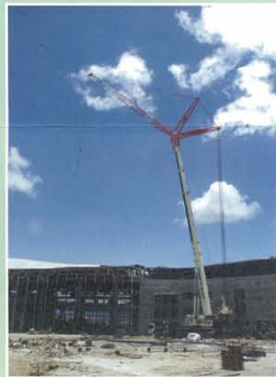
↑80噸重的巨大吊車吊載壓克力玻璃之用
