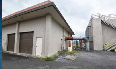
馬達將海水運送至海水處理廠（左）及臭氧接觸槽（右）
