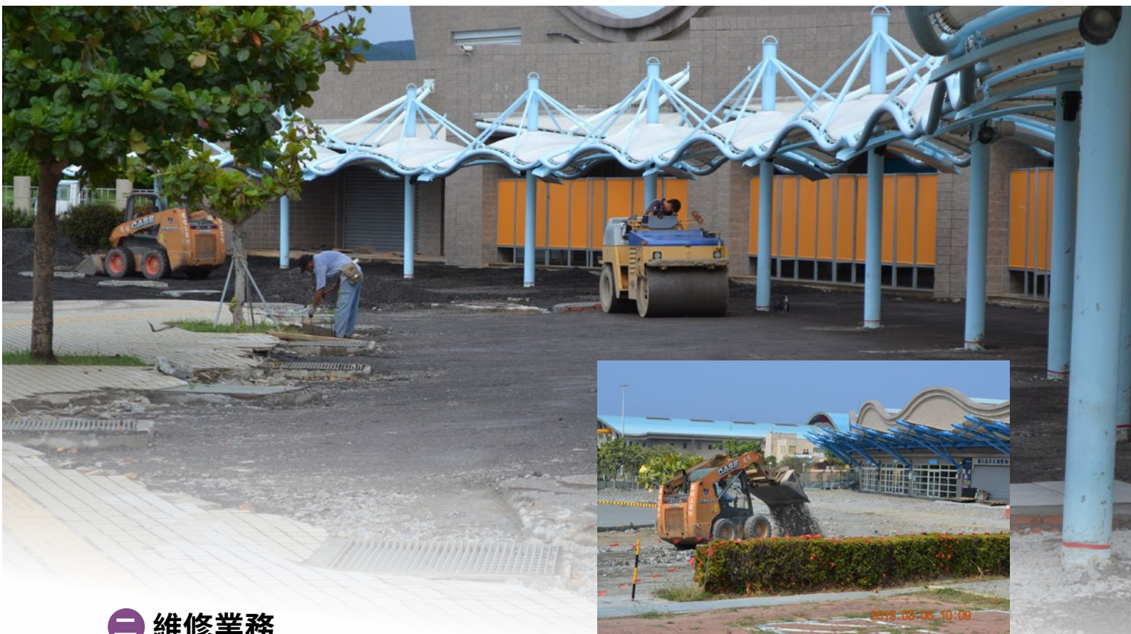
海景公司壓花地坪施工。
