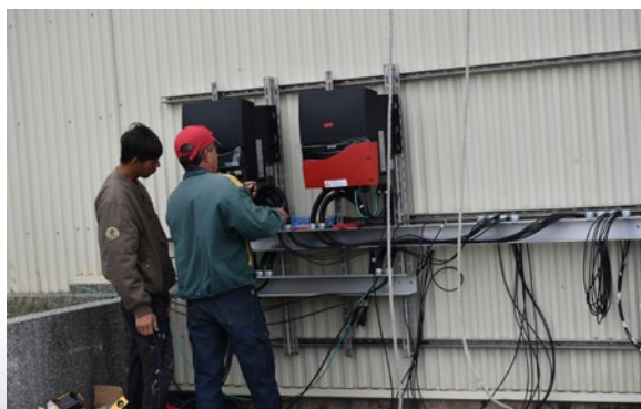
太陽光電案配電箱施工。
