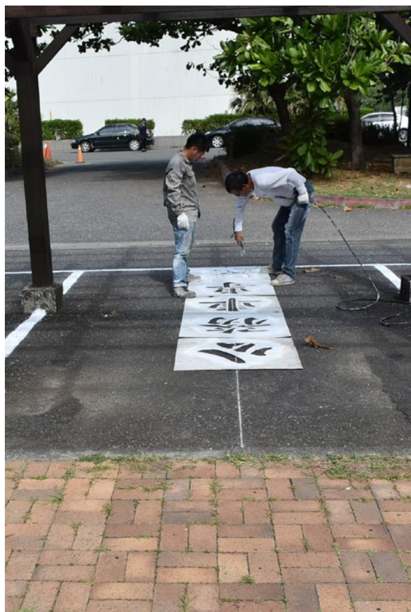
行政停車場標線施工。
