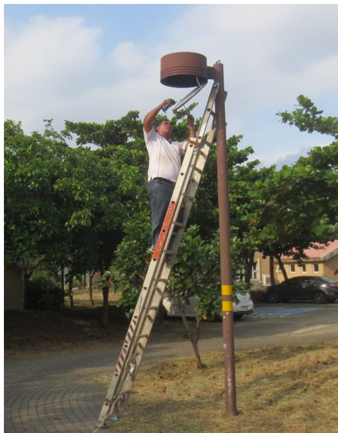
館區路燈設備查修。
