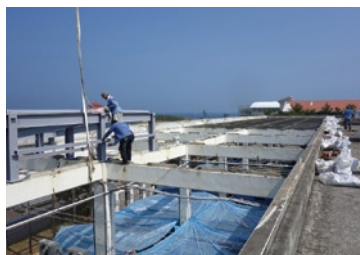
▲圖5. 遮雨棚施工。
